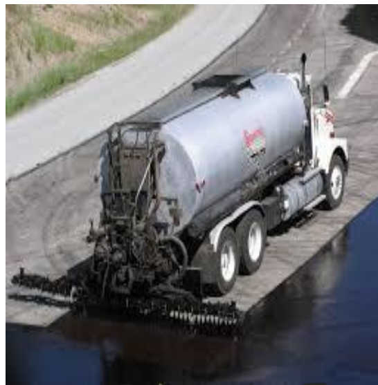
بد رقيقه عادية Emulsified asphalt مخلو بماء
